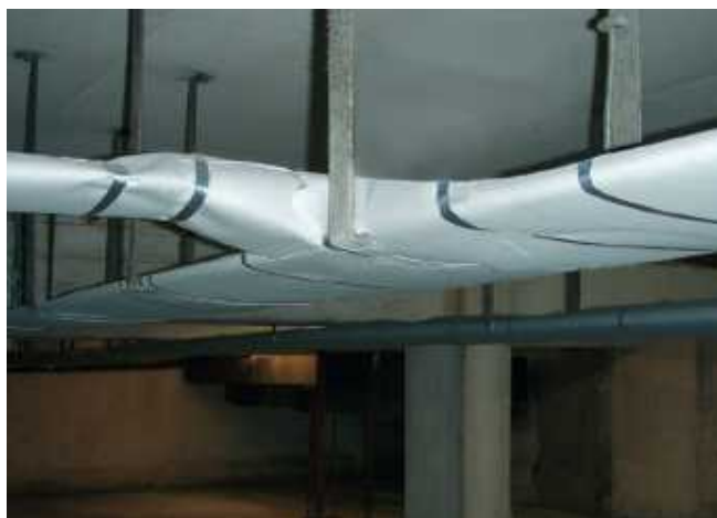
Applicazione di PYRO-SAFE DG su canalina portacavi
